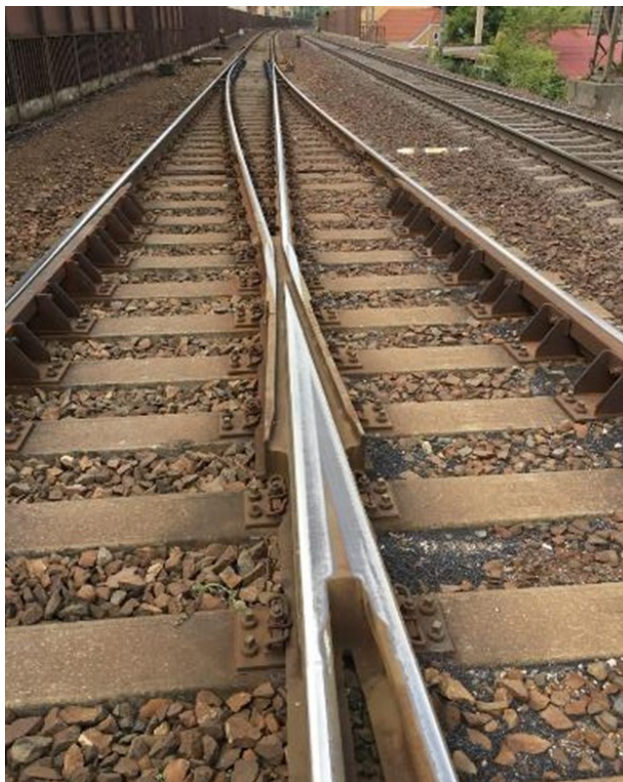
Obrázek 2 – Srdcovka ve výhybce v trati
